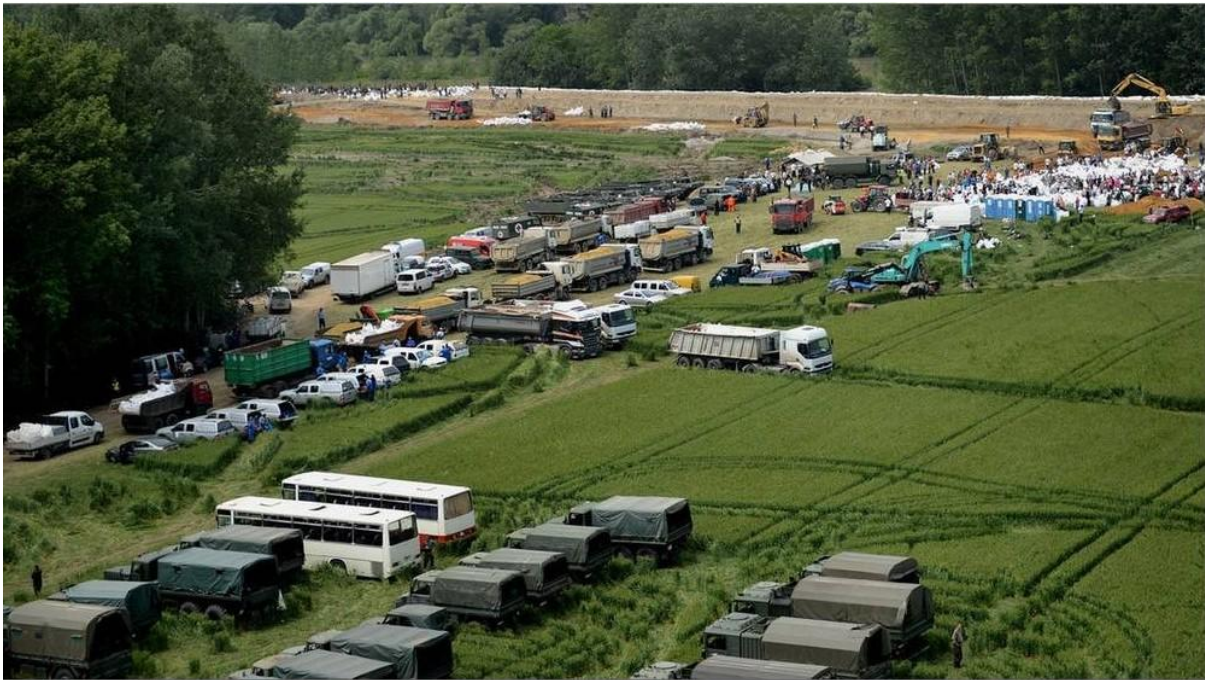
7. kép. Árvíz elleni védekezés, Győrújfalu 2013. [6]
