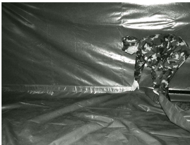
7. ábra – Aljzatfólia felcsatolása
