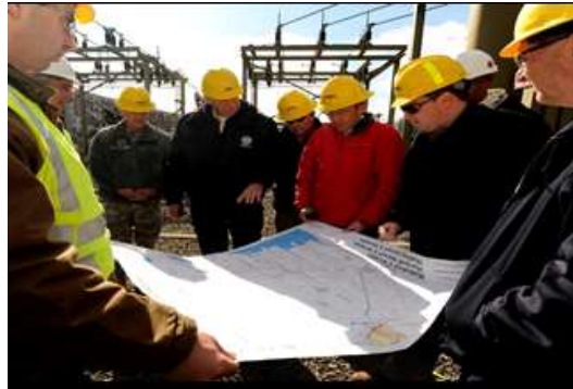
5. ábra. A Hobokeni elektromos állomás helyreállítási munkálatainak megbeszélése – FEMA részéről Rich Serino (balról a harmadik); Energiaügyi Minisztérium államtitkára Chu (piros kabát), illetve a Közszolgálati Villamos és Gázipari Részvénytársaság mérnökei [7]
