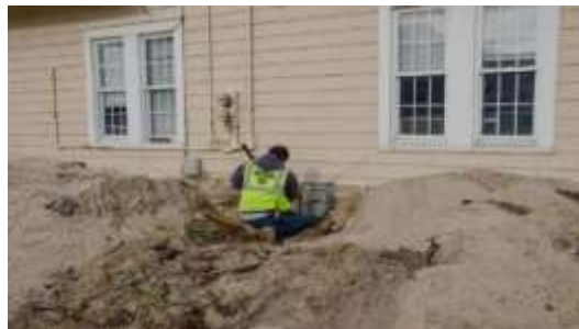
6. ábra. Földgáz hálózat helyreállítása Long Beach (New York), 2012. november 20 [8]
