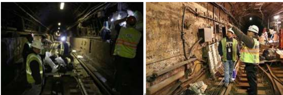
7. ábra. Port Authority Trans Hudson (PATH) villanszerelőinek javító munkálatai az elektromos rendszerek sérülései miatt - Hoboken [9]
