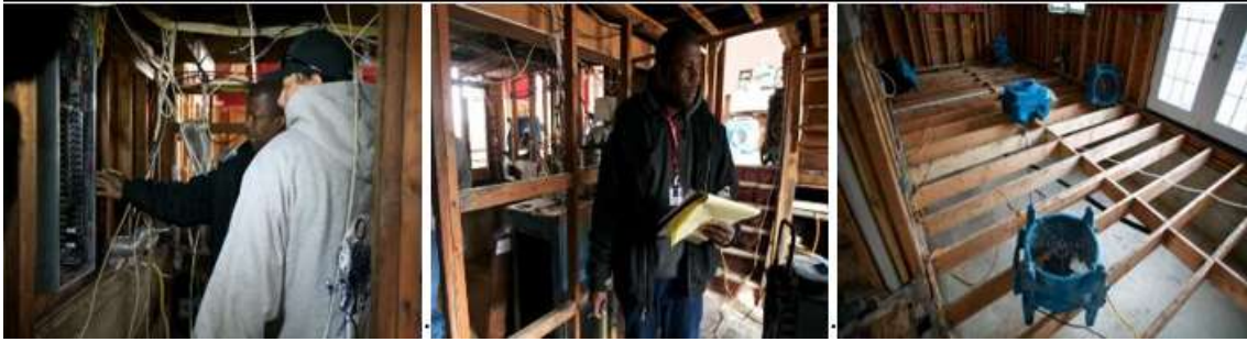
12. ábra. Villanszerelők, ácsok és a vízvezeték-szerelők vizsgálják át az Oceanside-i otthonokat a FEMA STEP program keretében [14]
