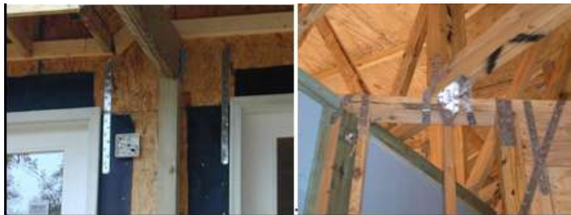
2. ábra. Tetőszerkezet megerősítése hurrikán hatásainak csökkentése érdekében [3]
