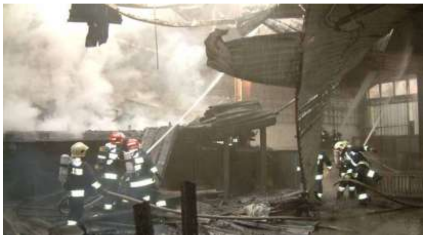
6. ábra. Acél trapézlemez tetőfödém maradványai egy gyártócsarnok tüzesete után. Műanyagtűz, a tűzfészek fölötti tetőfödém-szakasz leomlott [7]
