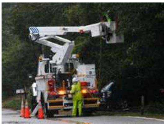
22. ábra. Javítási munka – Colington sziget (Észak-Carolina) [32]
