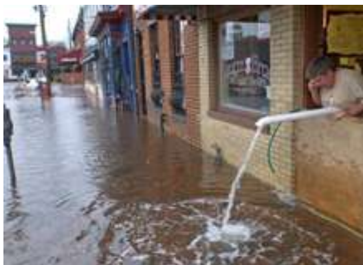
21. ábra. Üzletben levő víz kiszivattyúzása 2012. október 30-án [31]
