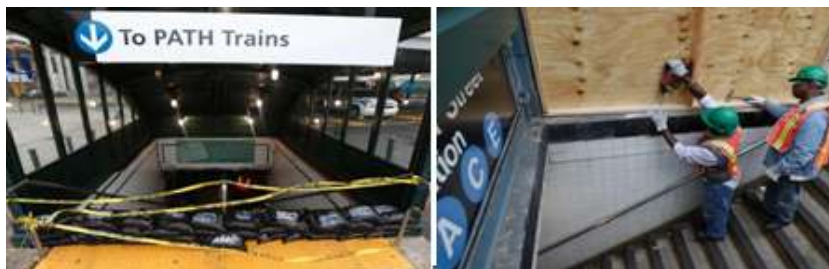
10. ábra. Balról: homokzsákkal védték a Hoboken-i vasút PATH állomását. Jobb oldali kép: a Közlekedési Hatóság emberei Canal Street A, C, és E-állomást fedik be rétegelt falemezzel október 27-én (New York) [14]
