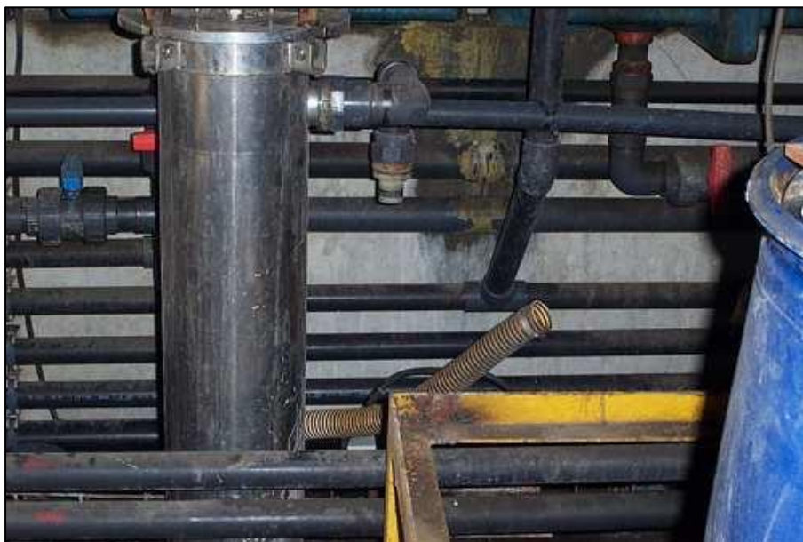
2. ábra A telephely szivárgó csöve, amely a szennyezést okozta [10]
