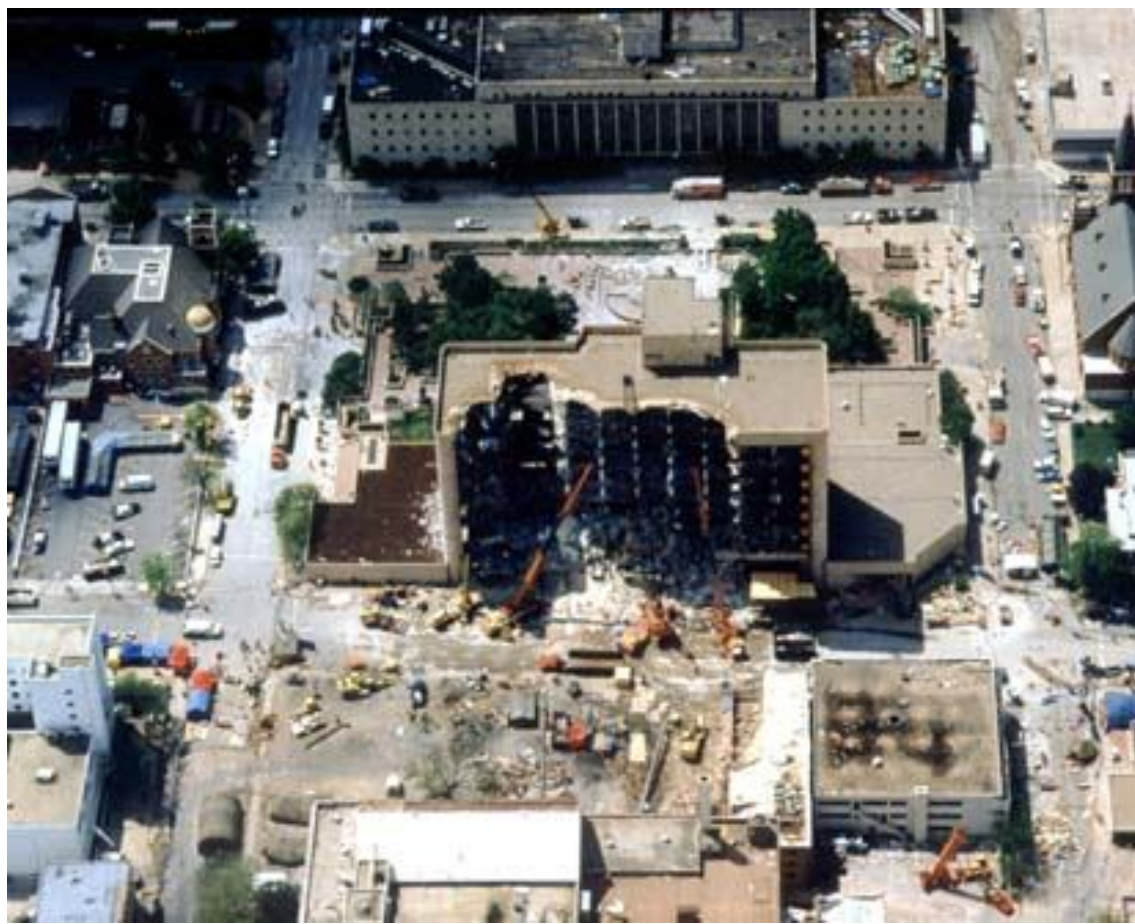
9. ábra Oklahoma City, Alfred P. Murrah Building a támadás után Forrás: www.wikipedia.org
