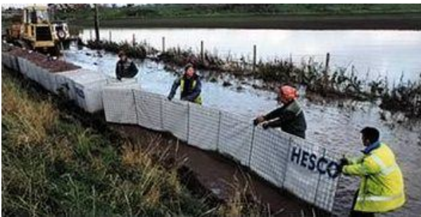
Az építőelemek telepítése árvízvédelmi töltésként 38
