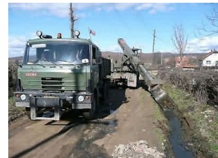
Vízvezető árok tisztítása 15
