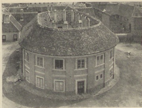
III. Harrer Pál u. 44. Az egykori selyemgombolyító épület főhomlokzata
