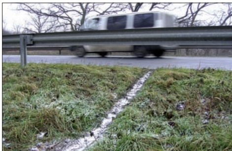
65. ábra: Halastavak közötti főúton átvezető, gyakran használt vidraváltó (nincs híd!)
