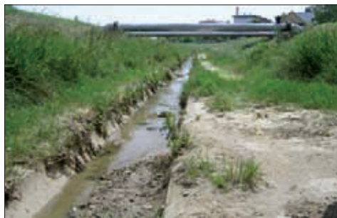
55. ábra: Kibetonozott (mesterséges) patakmeder
