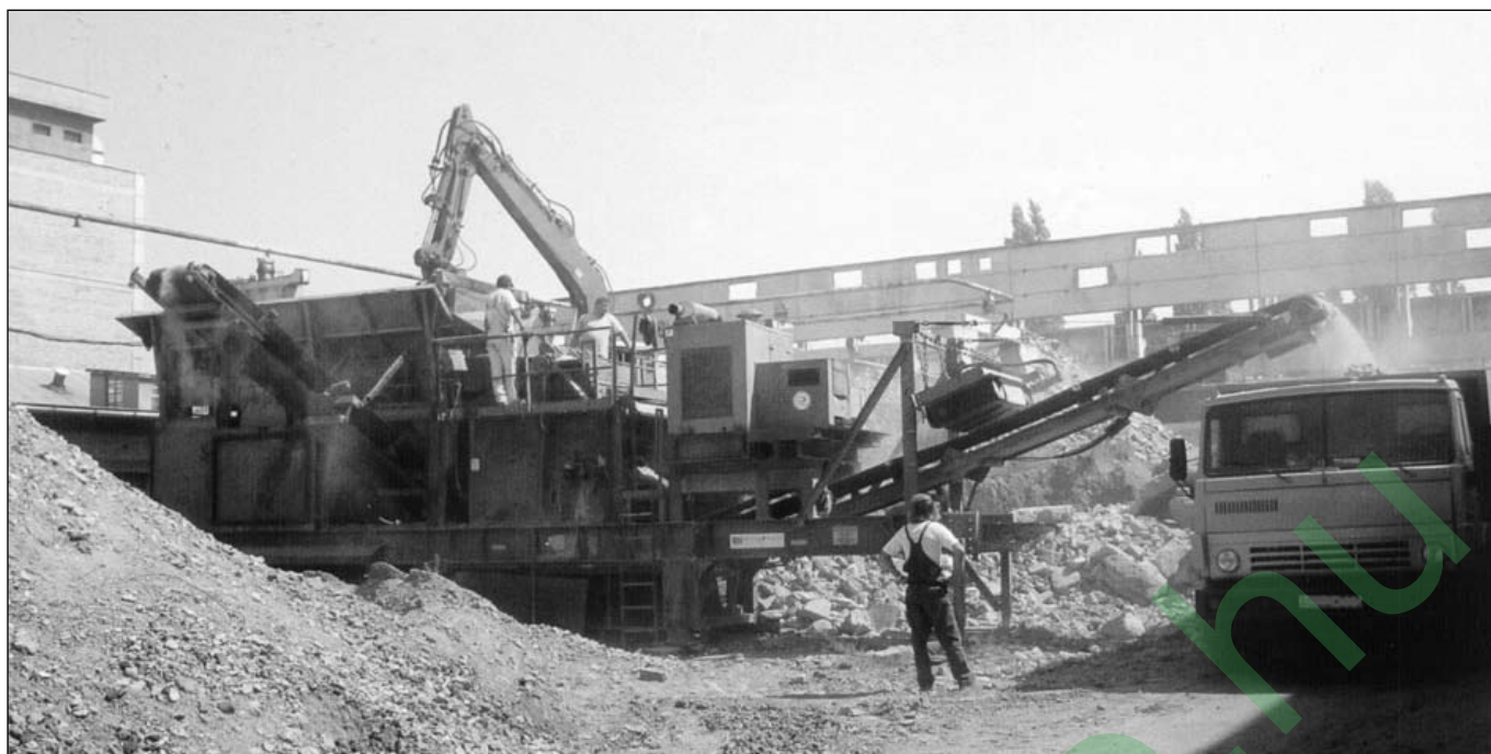
Fig. 2: Processing of demolition waste (Kiss és Társa Inc. Co., Budapest)
