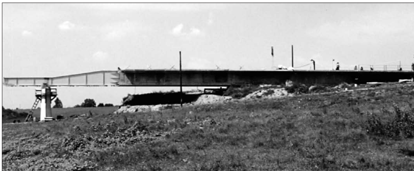
Fig. 16: Berettyó River Bridge
