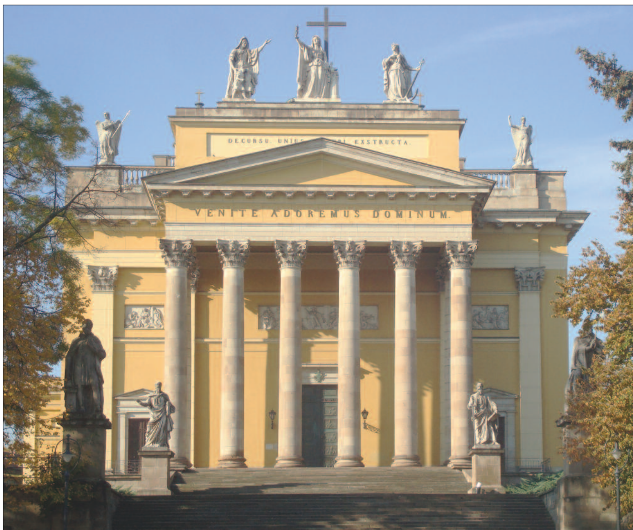
1. ábra. A székesegyház homlokzata
