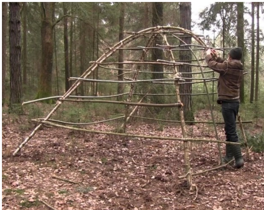
17. számú kép: Kerek tetejű menedék készítése 19
