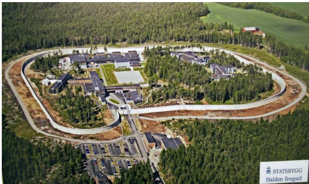
1. sz. fénykép: A Halden Börtön panoráma felvétele, melyet a parancsnok bocsátott rendelkezésemre
