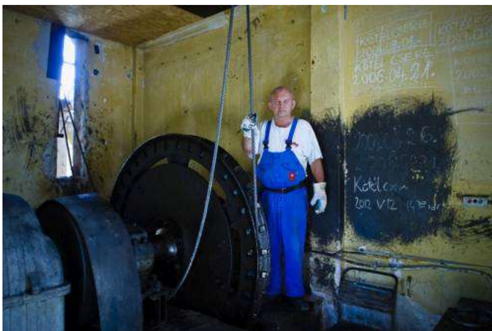
A Hullámvasút felhúzó gépezete
