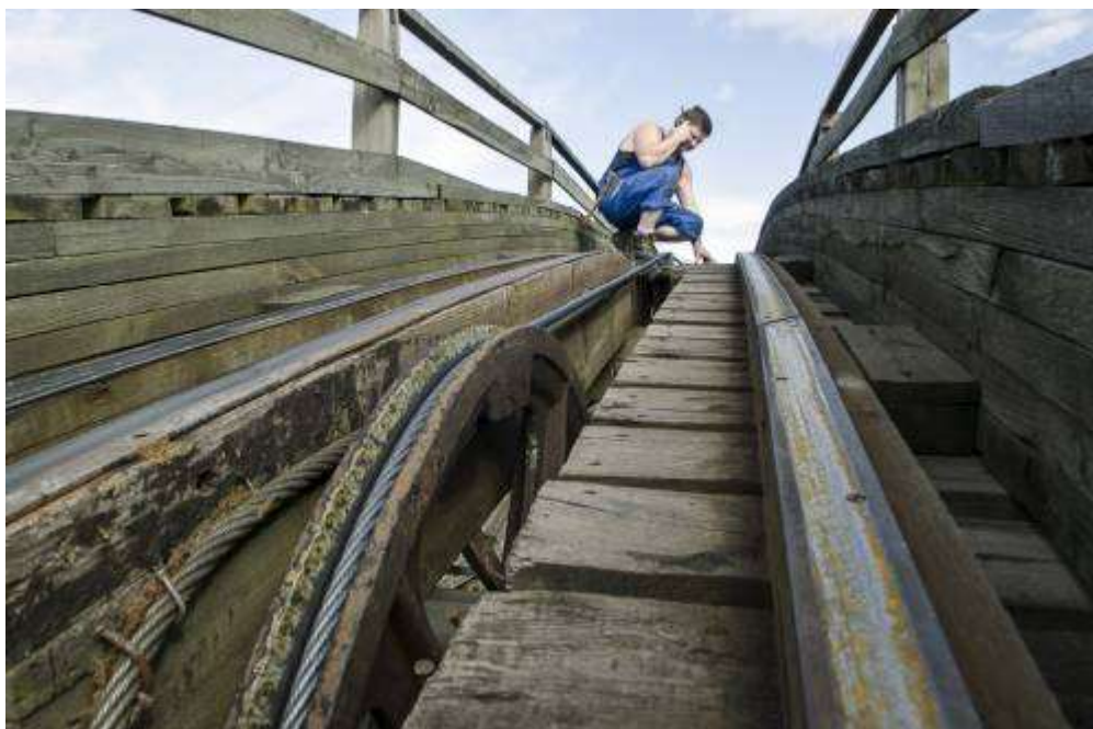
A szerkezet anyaga túlnyomórészt borovi fenyő
