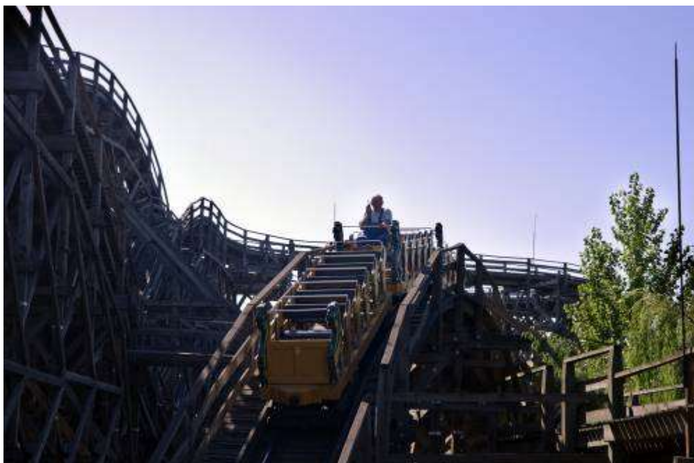
Fajtáját tekintve favázás szerkezetű kényszerpályás hullámvasút
