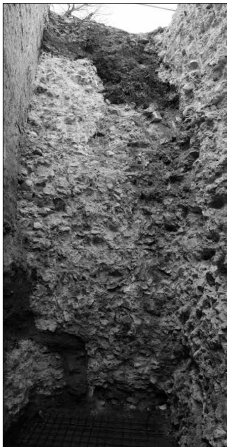
5. kép Az elbontott török kori várfal a liftakna helyén
