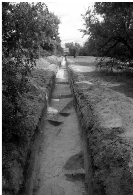
12. kép: A csatornaárok északi szakasza
