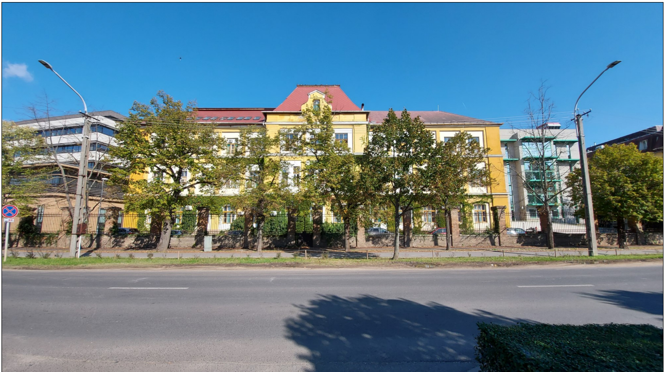
Múlt és jelen: az 1900-ban átadott gyulai belgyógyászati pavilon a modern diagnosztikai és műtéti tömb ölelésében
