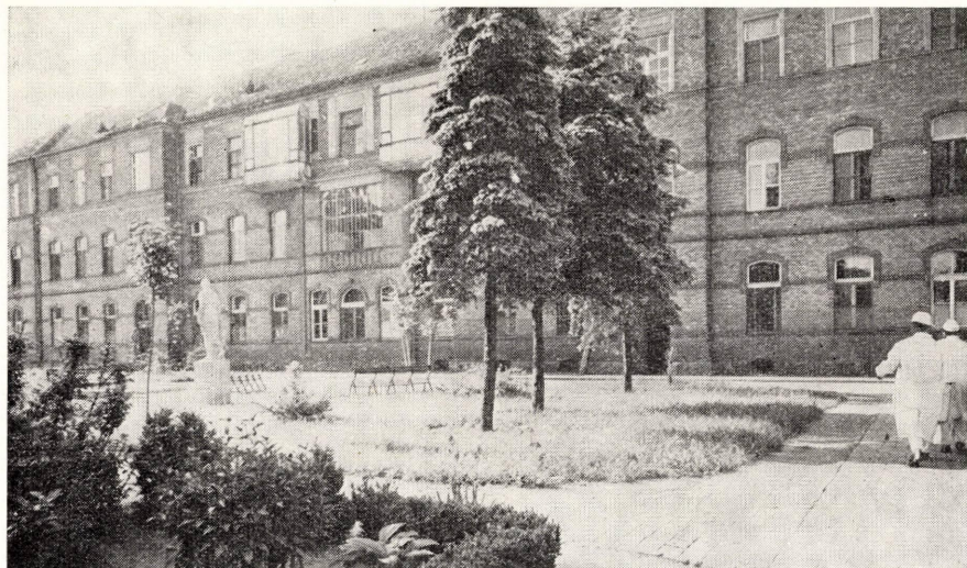
7. ábra : A főépület a II. emelet ráépítése után, 1929.
