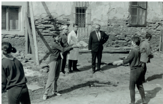
Az új épületszárny előkészítése (1960-as évek vége)
