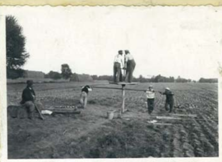
2. ábra. Robbantólyuk fúrása kézi erővel.
