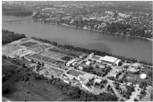
11. ábra. Észak-Pesti Szennyvíztisztító Telep III. fokozat, (1,035 millió LE, 200.000 m^3/d ) (1982-2010) (Fotó: FCSM archívum) Figure 11. North-Pest Waste Water Treatment Plant, III. development stage (1.035 million PE, 200.000 m^3/d ) (1982-2010) (Photo: FCSM Archive)
