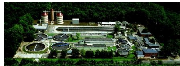
12. ábra. Nyíregyházi Szennyvíztisztító Telep, 160 000 LE (2001) (Fotó: Nyírségvíz Zrt. archívum) Figure 12. Nyíregyháza Waste Water Treatment Plant, 160 000 PE (2001) (Photo: Nyírségvíz Ltd Archive)
