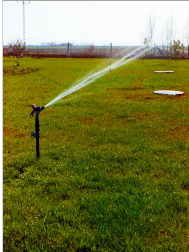
6. kép. Kecskemét - Felszín alatti nyomóvezetékű öntözőszórófej (Fotó: Vértesi L.)
