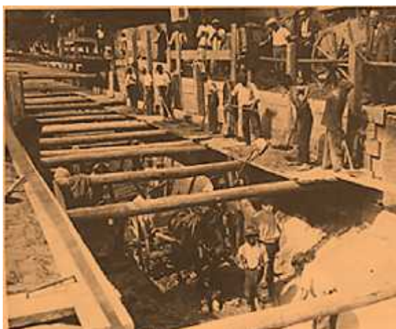
Figure 3. Construction of sewerage main in 1910 (Source: Budapest csatornázása: Pest város 1847. évi csatornázási szabályrendeletének 125 éves évfordulójára 1972)
