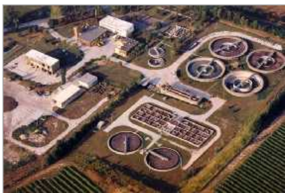
Figure 9. The combined biological devices of the Inotai-Juhász type Balatonlelle plant (1973) (Source: A szennyvíztisztítás története 2011)
