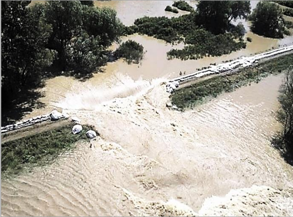
3. kép. Töltésszakadás a Hernádon (2010. június) Photo 3. Dyke burst in Hernád (June 2010)
