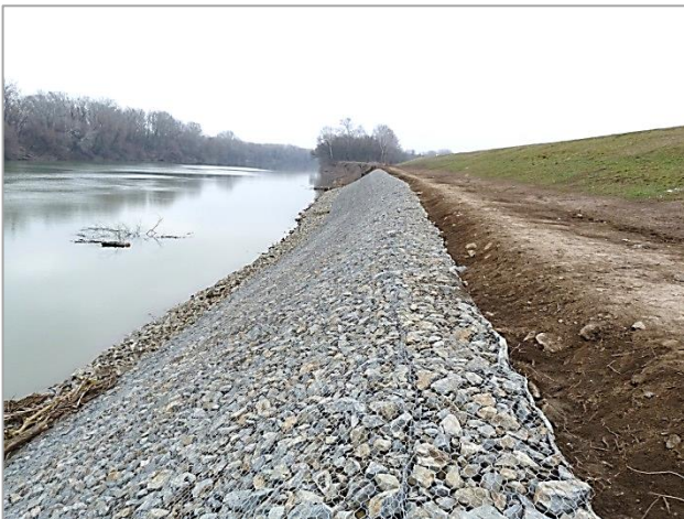
3. kép. A Tisza folyón Algyőnél elkészült partbiztosítás (Fotó: ATIVIZIG)
