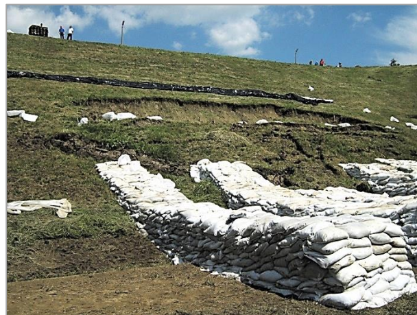
9. kép. A Hasznosi tározó rézsúcsúszása (2010. 05.23.) Photo 9. Slope failure of the Hasznos Reservoir (23.05.2010.)
