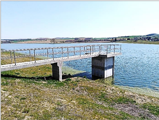
4. fénykép. A Barátúri tó vízfelülete Photo 4. Water surface of Lake Barátúri
