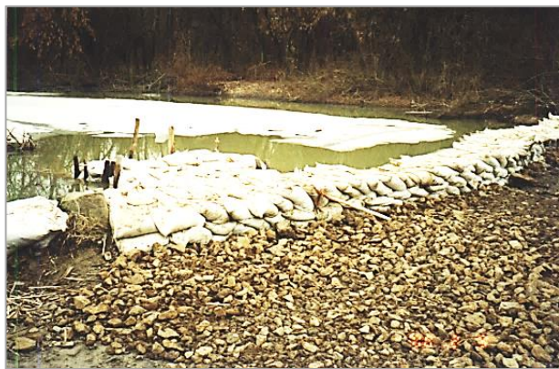
3. kép. Homokzsákkal elzárt tározóbéli vízfolyás (Saját szerkesztés archív felvétel alapján)
