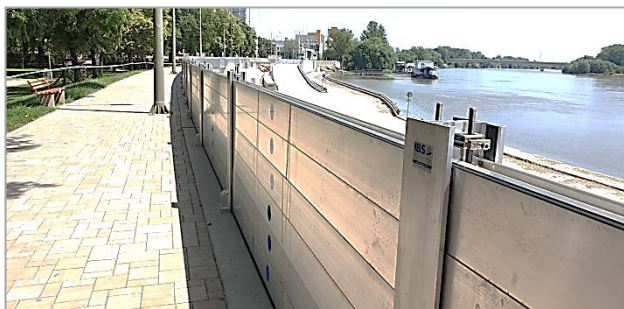
2. kép. Szegedi mobil árvízvédelmi fal (Fotó: Kozák P.) Picture 2. Mobile flood protection wall in Szeged (Photo: P. Kozák)
