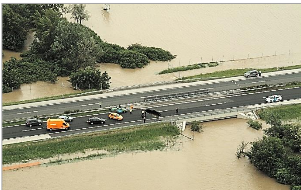
8. kép. Útpálya-beszakadás az M1 autópályán a Cuhai-Bakony-ér hídjánál (2010.05.19.) Photo 8. Road collapse on the M1 motorway at the Cuhai-Bakony-brooklet bridge (19.05.2010)
