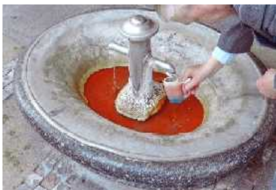
8. ábra. Ivókút meszes-vasas kiválásokkal
