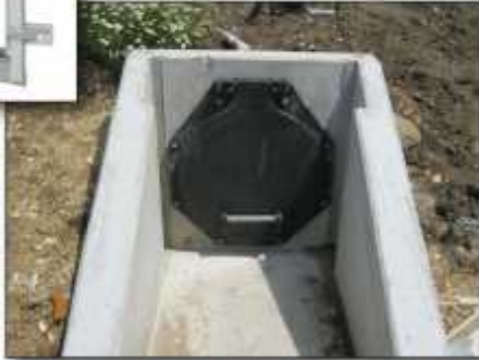
Zsilipek, csappantyúk korrózióálló acélból vagy HDPE műanyagból
