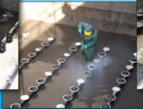
Szennyvíztisztító telepek levegőztető rendszereinek telepítése, felújítása, tisztítása
