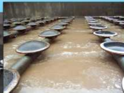
Szennyvíztisztító telepek levegőztető rendszereinek telepítése, felújítása, tisztítása
