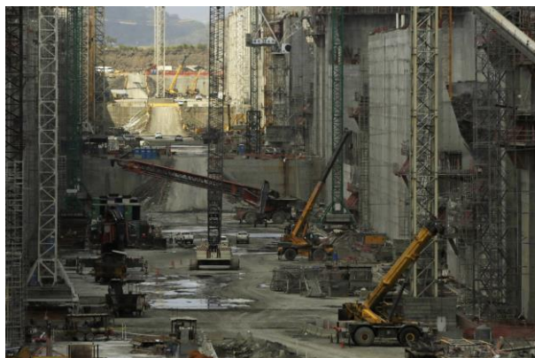
13. kép. Az épülő új zsilip az Atlanti-óceáni (Karib-tengeri) oldalon Picture 13. New lock construction on the Atlantic side
