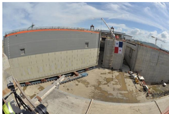
11. kép. A zsiliptábla beillesztése a zsilipkamrába Picture 11. The lock gate into the lock-chamber
