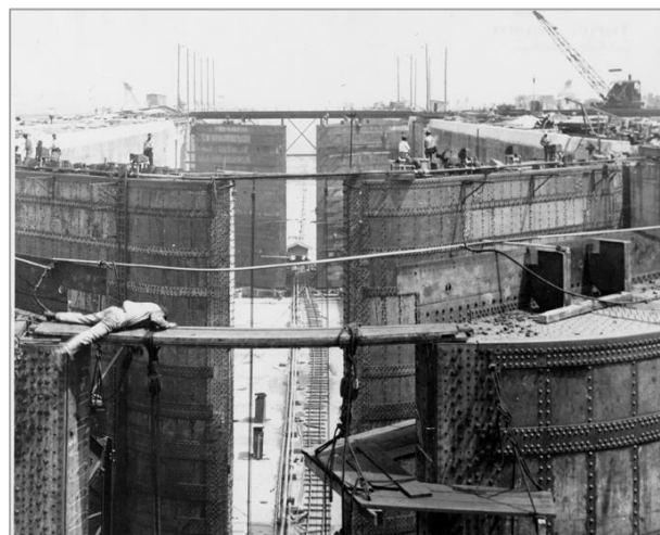
6. kép. Gatun zsilipek építés közben 1913-ban Picture 6. The construction of the Gatun locks in 1913
