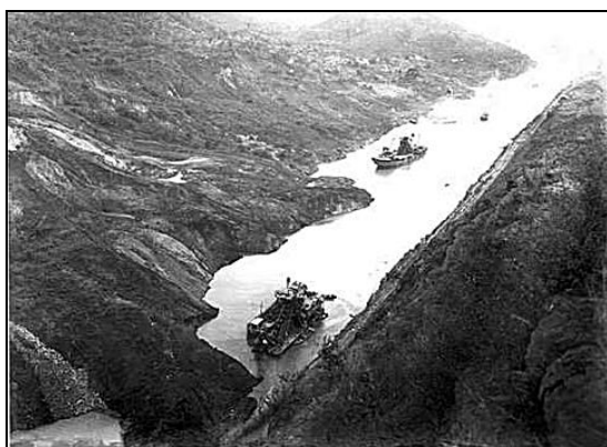
5. kép. 1913-ban a Culebra árokba becsúszott talaj Picture 5. A slope slide in the Culebra cut in 1913
