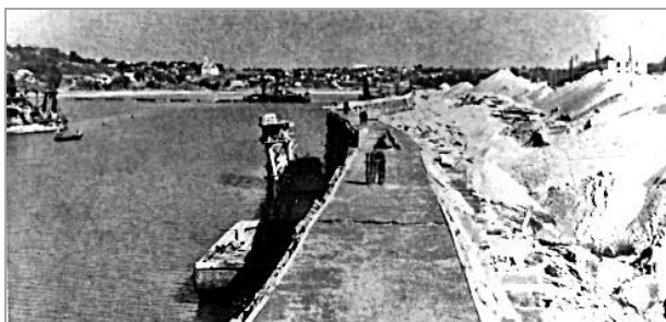
3. kép. A megcsúszott kikötő partfala (a partfal alsó részét nem töltötték fel zúzott kővel)
