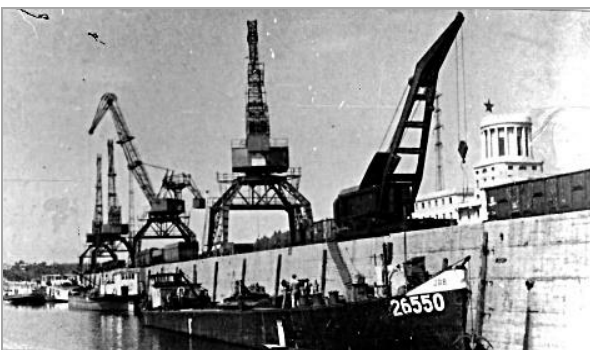
2. kép. A kikötő partfala a darukkal (befejezett állapot) Photo 2. The harbour embankment with the cranes (in accomplished condition)
