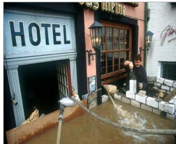
6. kép. Lokális árvízvédelem magasítása a Duna mellett Ausztriában Photo 6. Emergency heightening at the bank of Danube in Austria
