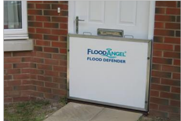
10. kép. Lokális árvízvédelmi megoldás Angliában Photo 10. Local flood protection in England
