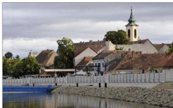
3. kép. Mobil árvízvédelmi fal Szentendrén Photo 3. Mobil flood wall in Szentendre (Hungary)
