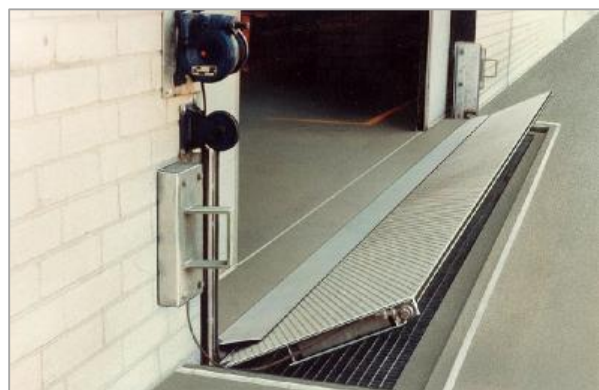
7. kép. Kapu védelme kis magasságú árvíz ellen Photo 7. Gate protection against low elevation flood water
