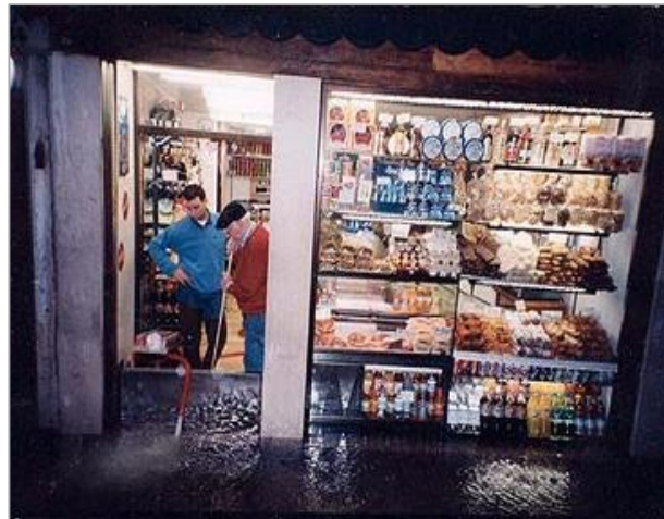
5. kép. Üzlet lokális védelme az olaszországi Velencében Photo 5. Local flood protection of a shop in Venice (Italy)
