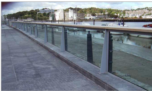
2. kép. Üveg árvízvédelmi fal Photo 2. Glass flood wall
