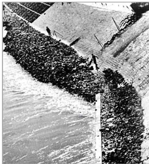
1. kép A vízierőmű jobb oldali, alvízi eróziója Photo 1. Erosion on the tailwater, right side of the barrage
