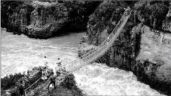
5. ábra Újjáépített inka függőhíd (Forrás: Wikipedia.com) Figure 5 Remodeled Inca suspension bridge (Source: Wikipedia.com)
