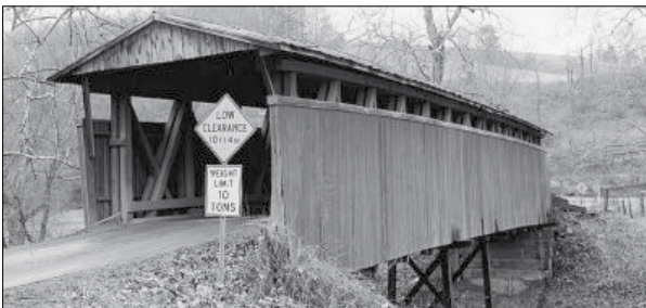
20. ábra Staats Mill híd Long-féle tartószerkezettel (Fotó: West Virginia, Division of Transportation, circa 1982)
