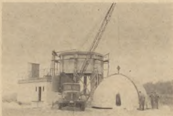
14. ábra. A Fűzfőgyártelepi Csillagvizsgáló kupolájának beemelése 1965. november 30-án
