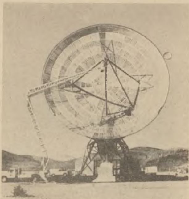
57. ábra. Nagyméretű mesterséges hold követő parabola-antenna, fókuszában mézer-erősítővel
