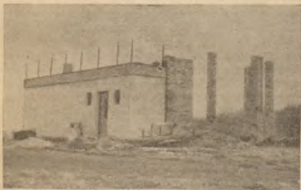
13. ábra. Az épülő fűzfőgyártelepi Uránia
