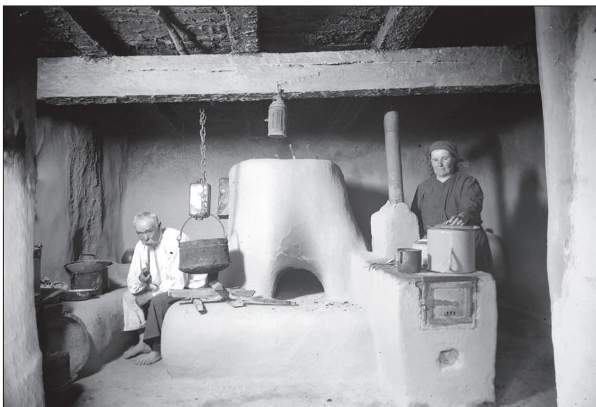
21. kép. Kemence, takaréktűzhely a konyhában, felettük mestergerendával. Kadarkút, Somogy m. (Ébner Sándor felvétele, 1931. Néprajzi Múzeum Fotótára Budapest, lelt. sz.: F 64949.)
