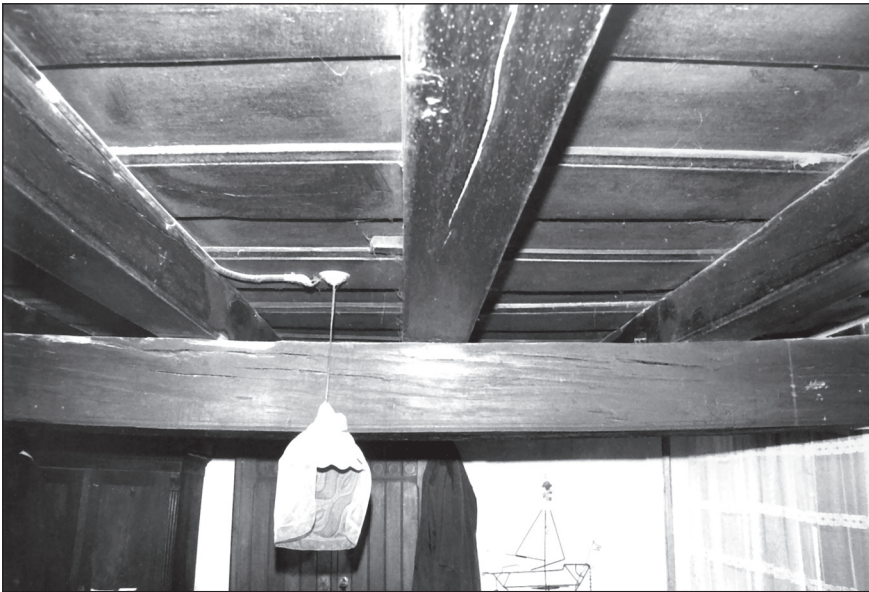
4. kép. Keresztirányú mestergerenda az első szobában. Kővágóörs, Vörösmarty u. 10. (Fotó: Lukács László, 1984.)
