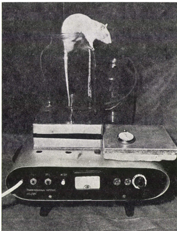
6. ábra. Elhárító reflex kiépítésére alkalmas hőingerteljes berendezés. Screening teszt II.
