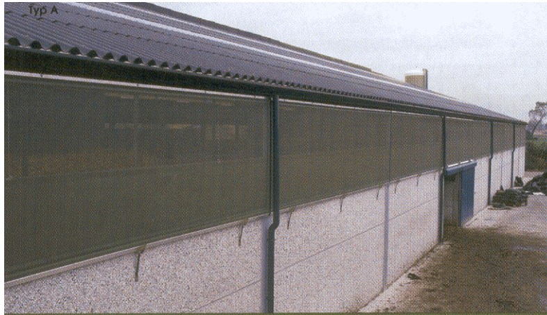
2. ábra: Változtatható oldalfalnyílású sertésistálló
