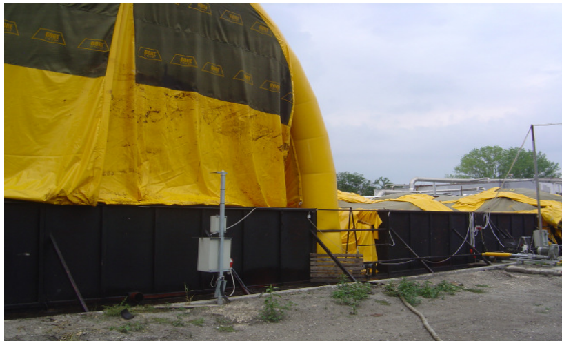
8. kép: A kültéri irányítástechnikai egység (ATEVSZOLG Zrt., Győr)
