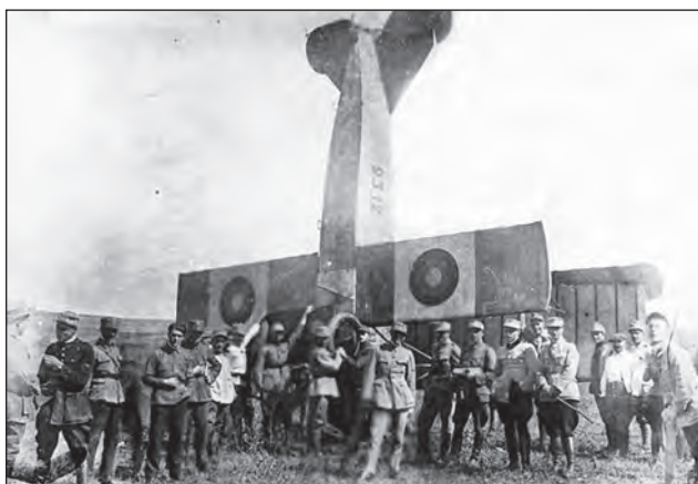
12. ábra. A románoknál orra állt 93.12-es. A MÁG-gyártású Fokkerok színe a valóságban a lakozott vászon miatt világos-sárga (homoksínű), a motorlemezek festetlen fémszínűek voltak (www.cartula.ro)
