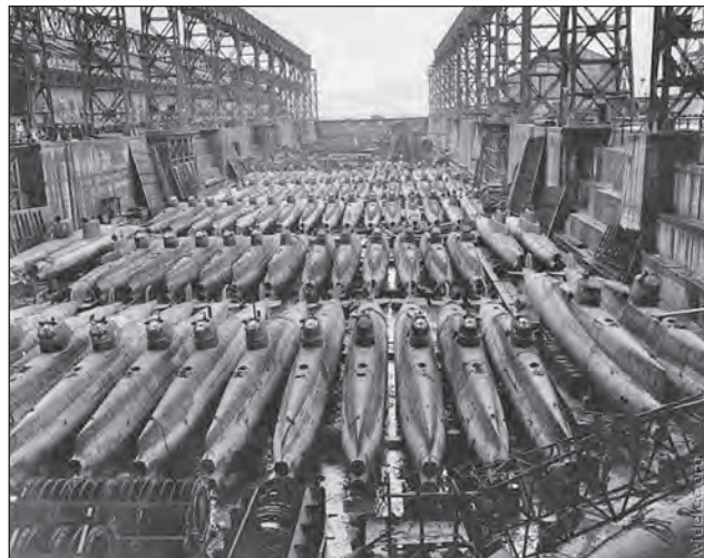
9. ábra. A Kure-i tengerészeti hajógyárban épülő, befejezetlen Kaiten típusú mini tengeralattjárók egy szárazdokkban. Amerikai felvétel 1945. szeptember
