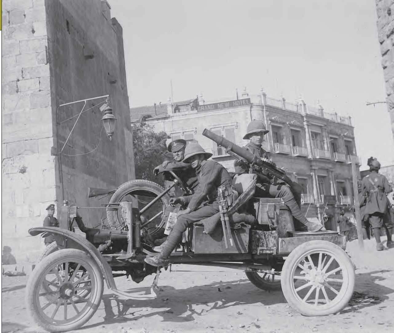
2. ábra. Lewis golyószóróval szerelt Ford Egyiptomban. Lebontottak minden felesleges karosszériaelemet, hogy könnyebb legyen az autó (Forrás: Library of Congress)
