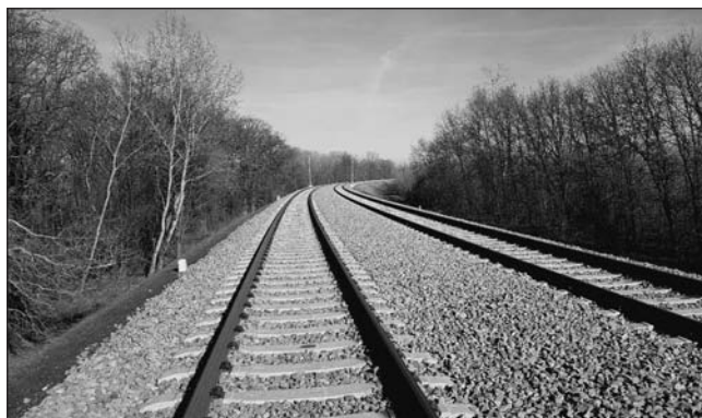
■ 7. ábra. Diósgyőrben kifejlesztett UIC 60 rendszerű sínrel üzemelő pályaszakasz
