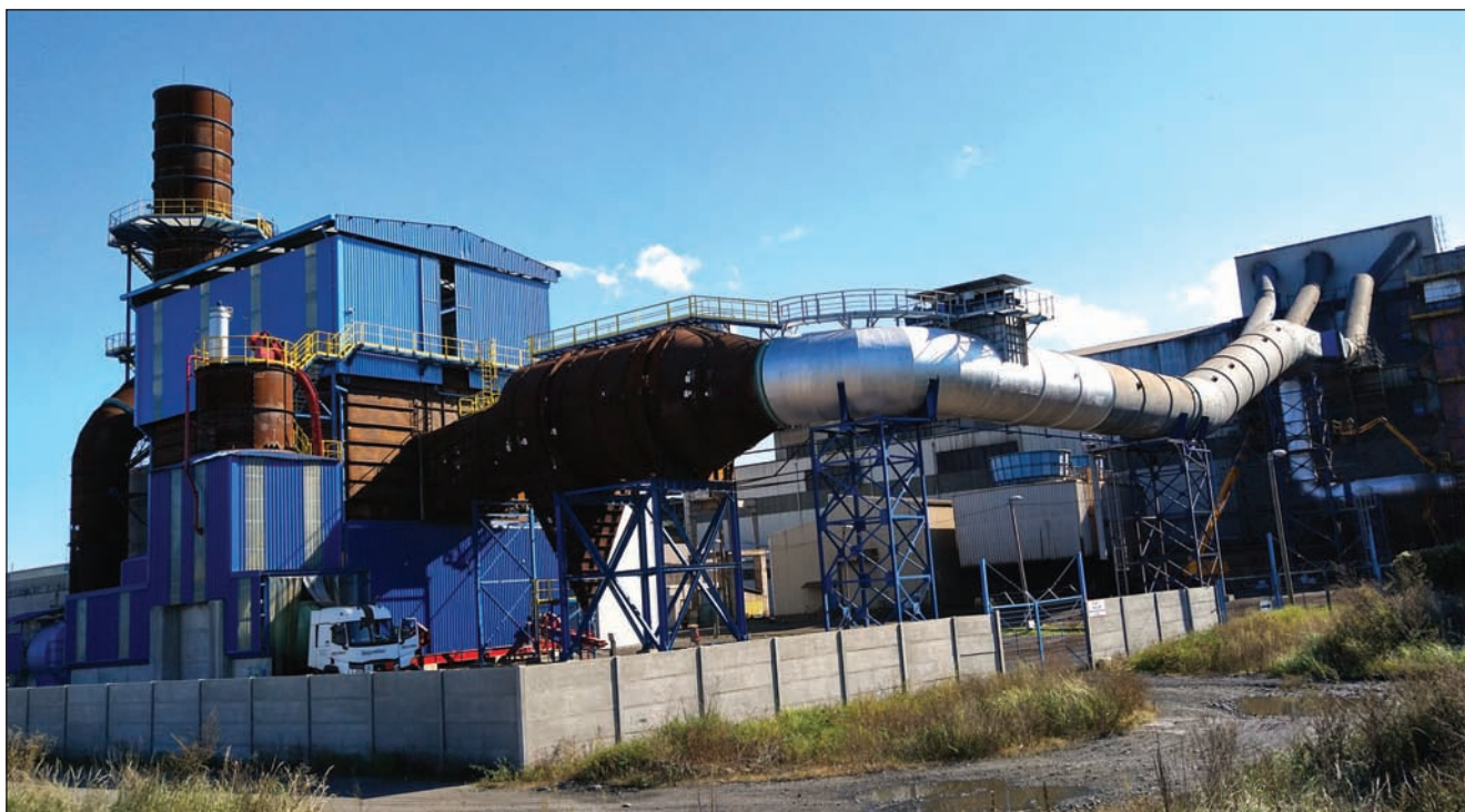
■ 4. kép. Ragyogó kék ég az Ózdi Acélmű felett, balra az új Danieli gyártmányú porgépház és a 4400 mm átmérőjű szívócső három-ágú, egyenként 2200 mm-es csatlakozása a jobb oldali ívkemence csarnokhoz
