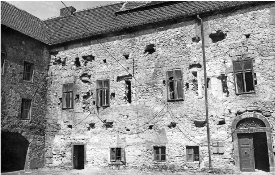
10. A keleti szárny udvari homlokzatának részlete, kutatás közben
