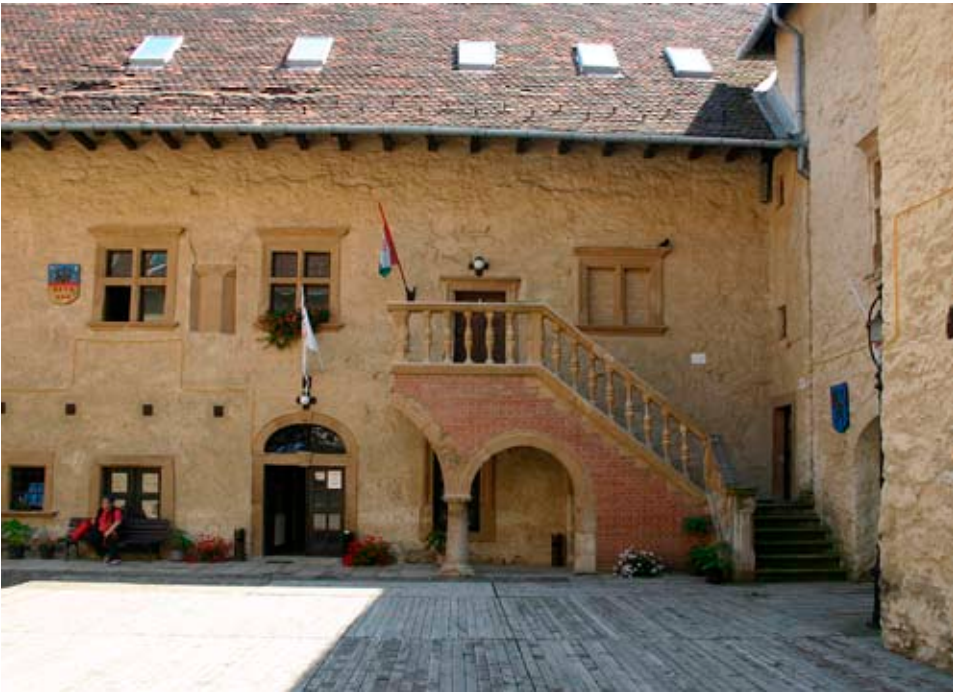
14. A keleti szárny külső homlokzata a rekonstruált külső lépcsővel és ajtóval
