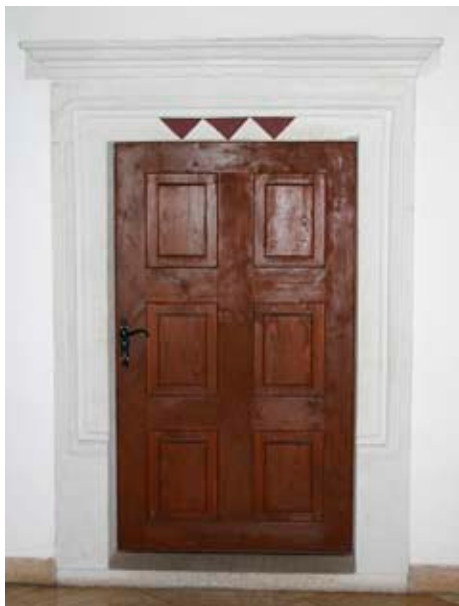
18. Rekonstruált ajtó a pitvar északi falában
