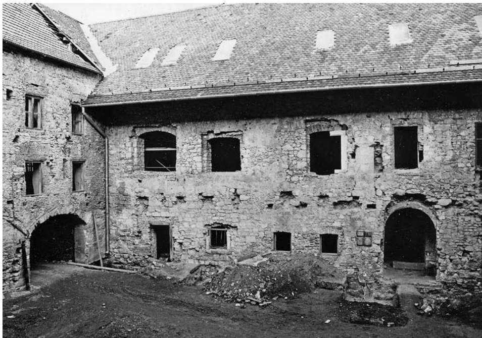
11. A keleti szárny udvari homlokzata helyreállítás közben
