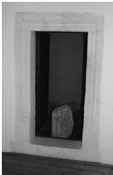
25. A rekonstruált árnyékszékajtó a toronyszoba délnyugati sarkában
