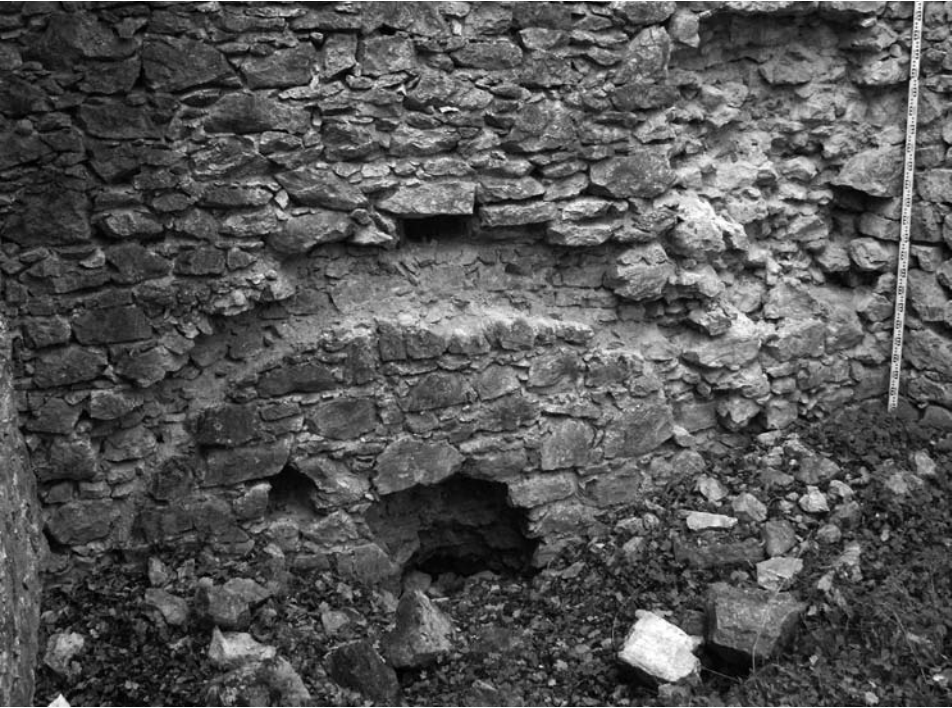
4. Zádorvár. A földszint dongaboltozatának lenyomata a DNy-i torony nyugati belső falán
