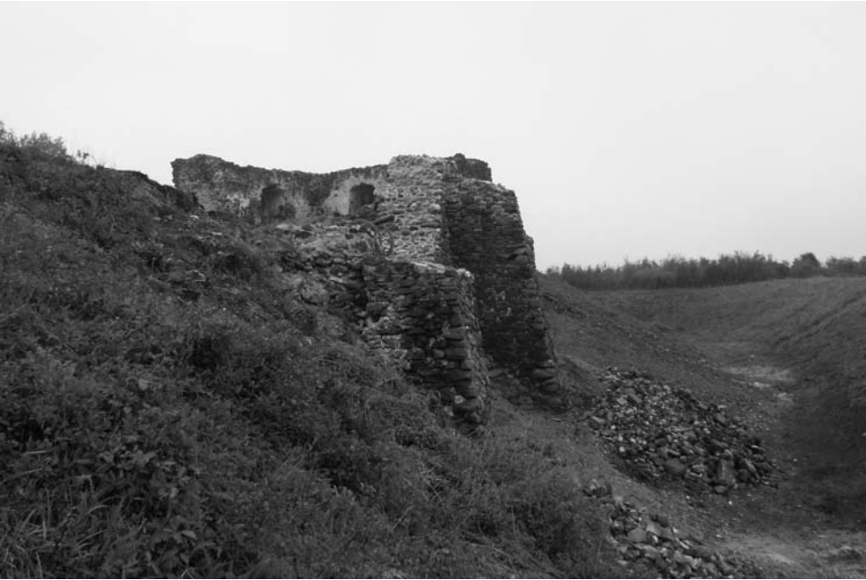
2. Csobánc vára. A 2007-ben kutatott várfalszakasz a helyreállítás után
