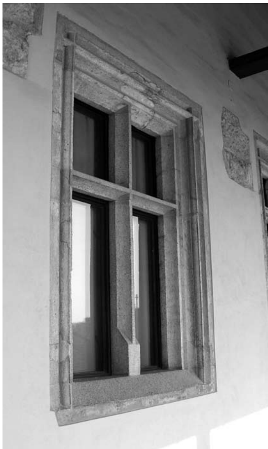
29. Az emeleti gótikus (8. sz.) ablaknyílás, felső sarkainál a lefaragott boltvállak (a szerző felvétele)
