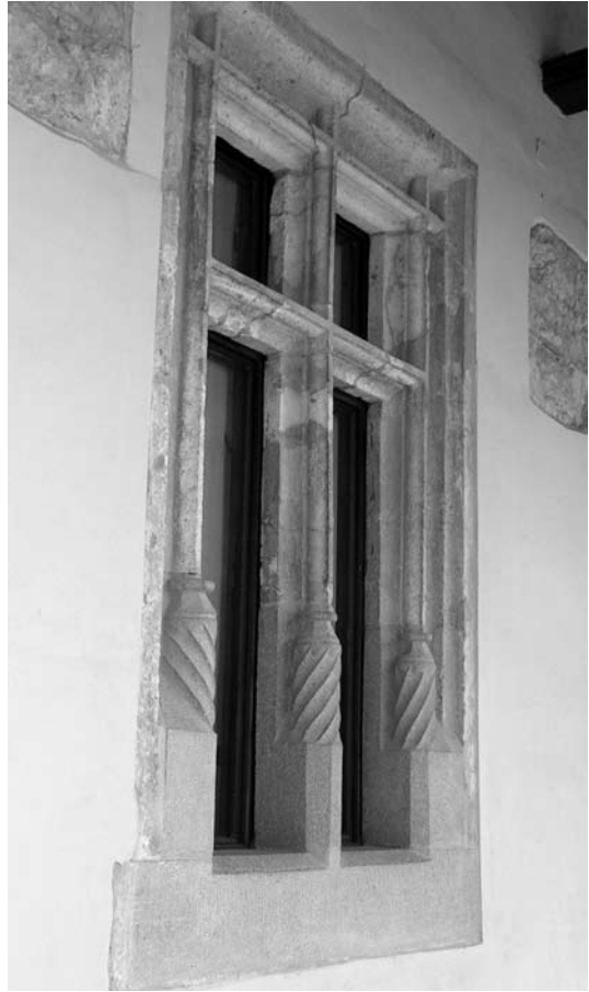
30. Az emeleti gótikus (9. sz.) ablaknyílás, felső sarkainál a lefaragott boltvállak (a szerző felvétele)
