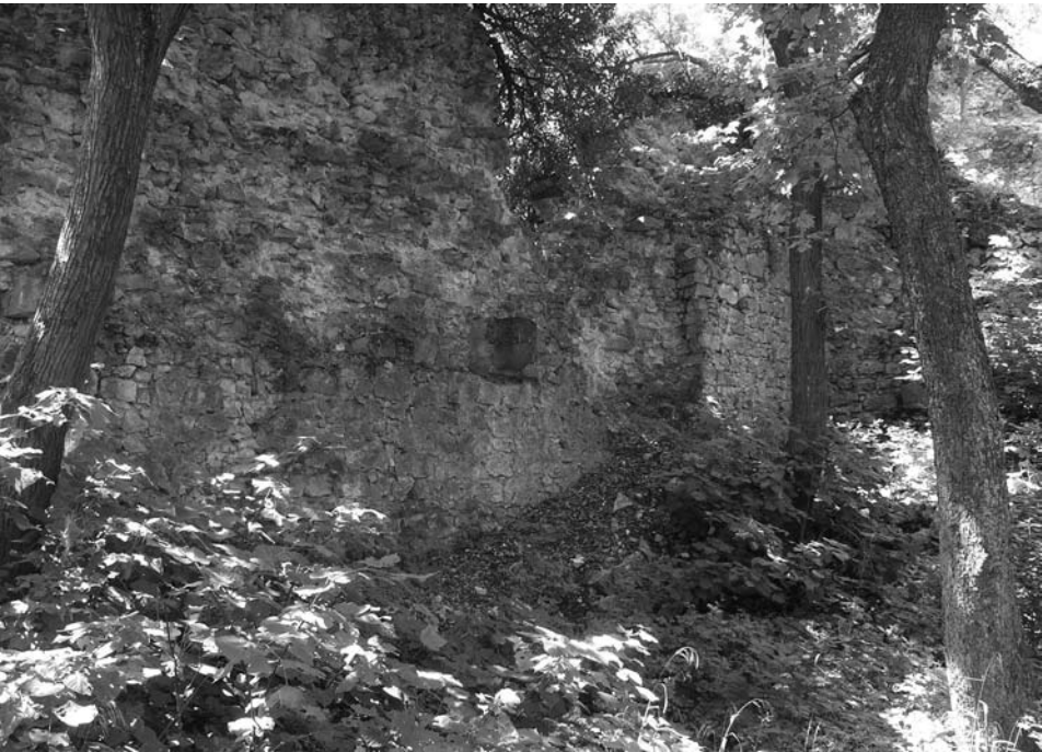
5. Zádorvár. A kaputól Ny felé eső belső várfalsík, háttérben a DNy-i torony csatlakozása
