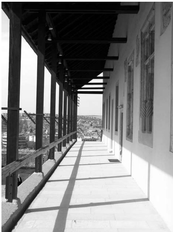
28. A rekonstruált emeleti folyosó K felől. A fa oszlopok a feltételezett eredeti pillérkiosztást követik (a szerző felvétele)
