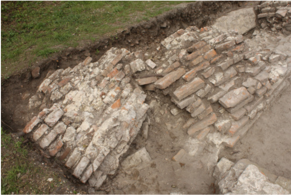
8. kép: A kaputorony Ny-i bővítésének leomlott DNy-i sarka
