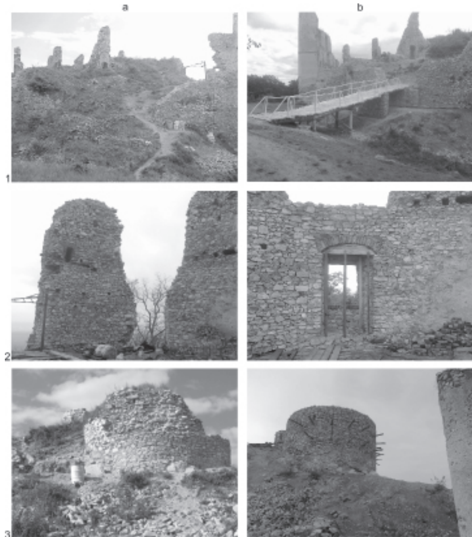
11. kép: 2015. 1. az I. várárok, a II. várfal és a várudvar északnyugati szakasza; 2. Teres ágyútornyóának ablaknyílása; 3. öregtorony; a. felújítás előtti állapot; b. felújítás utáni állapot. Fotó: P. Sater
