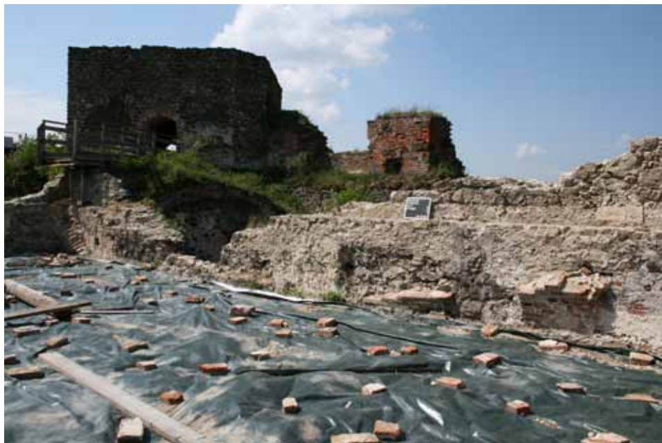
10. kép: A földszinti 5. tér nyugati fala az emeleti falak csonkjával és az újabb boltindításokkal, a háttérben az Újlaki-torony (fotó: Doris Schön)
