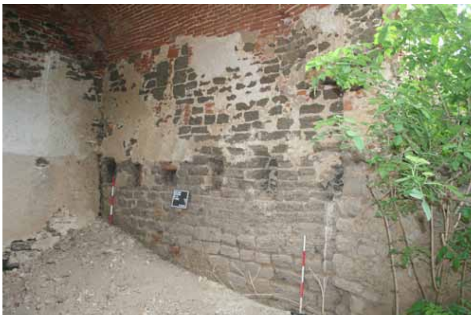
6. kép: Alagsor, 10. tér, déli fal az elfalazott lőrésablakkal (fotó: Doris Schön)
