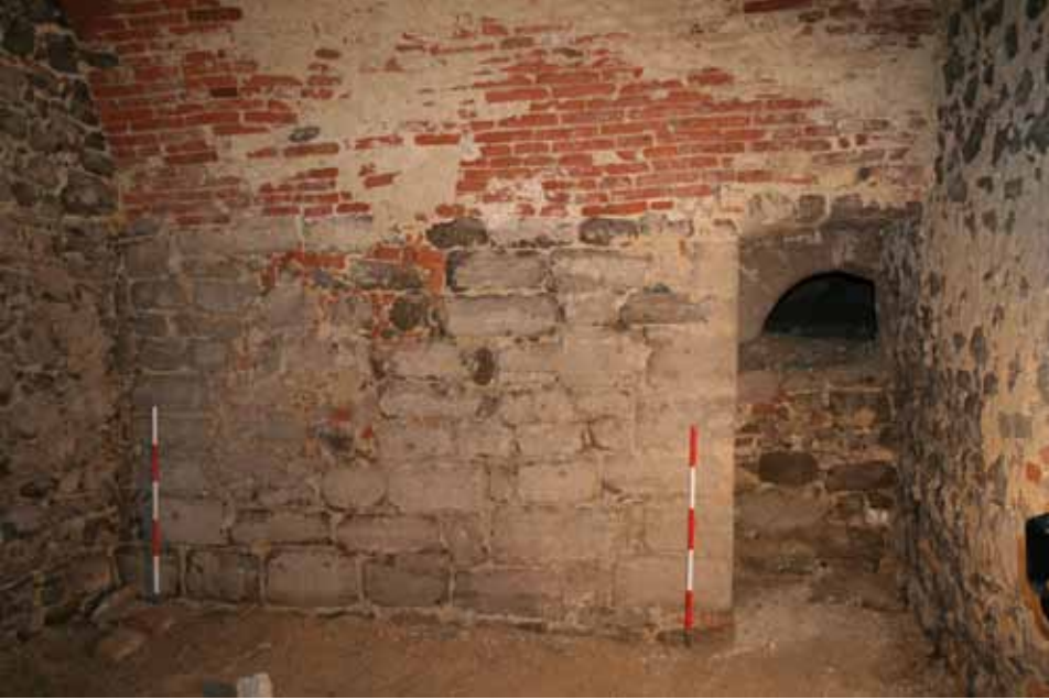
4. kép: Alagsor, 1. tér, az északkeleti fal a részben elfalazott bejárattal és az elfalazott ablakkal (fotó: Paul Mitchell)
