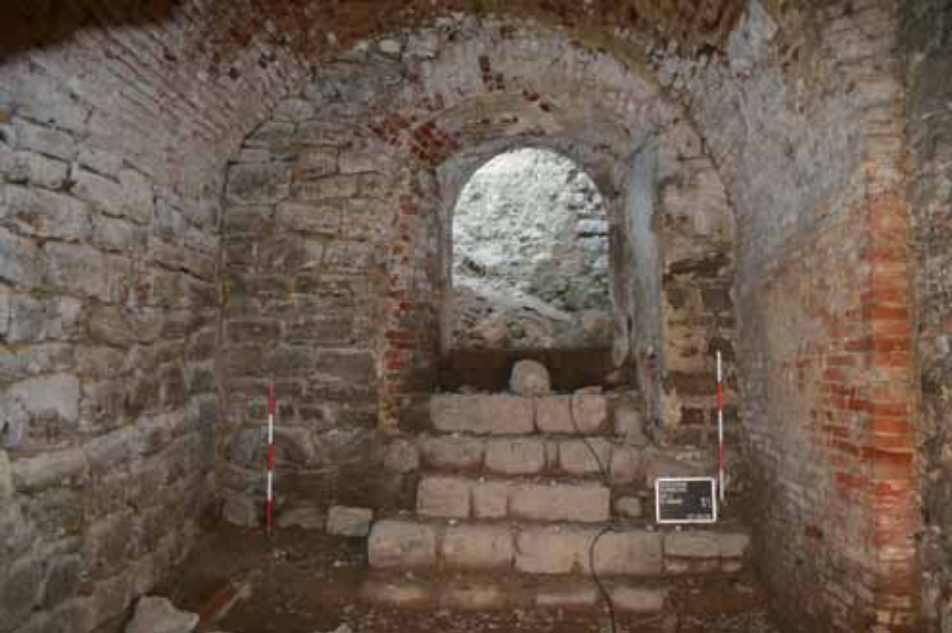
5. kép: Alagsor, 2. tér, a délkeleti fal a később bővített ajtónyílással (fotó: Paul Mitchell)
