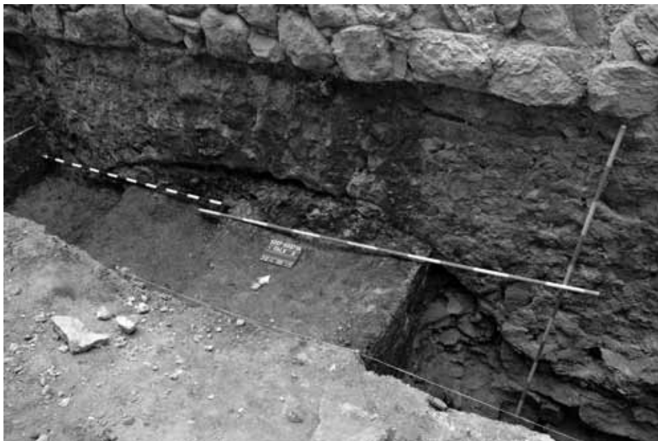
25. kép A Szép-bástya déli fala előtt ásott alapkutató árokban és az attól nyugatra előkerült teherhárító ív egy része (a szerző felvétele)
