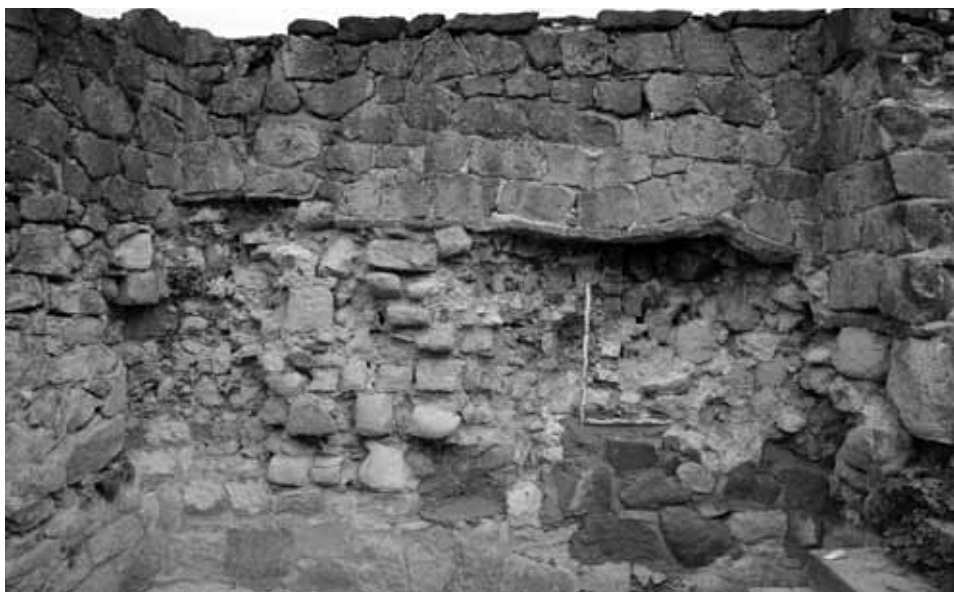
35. kép A nyugati várfal belső oldalán levő északi helység (Ny/1.) északi fala a helyreállítás előtt.
