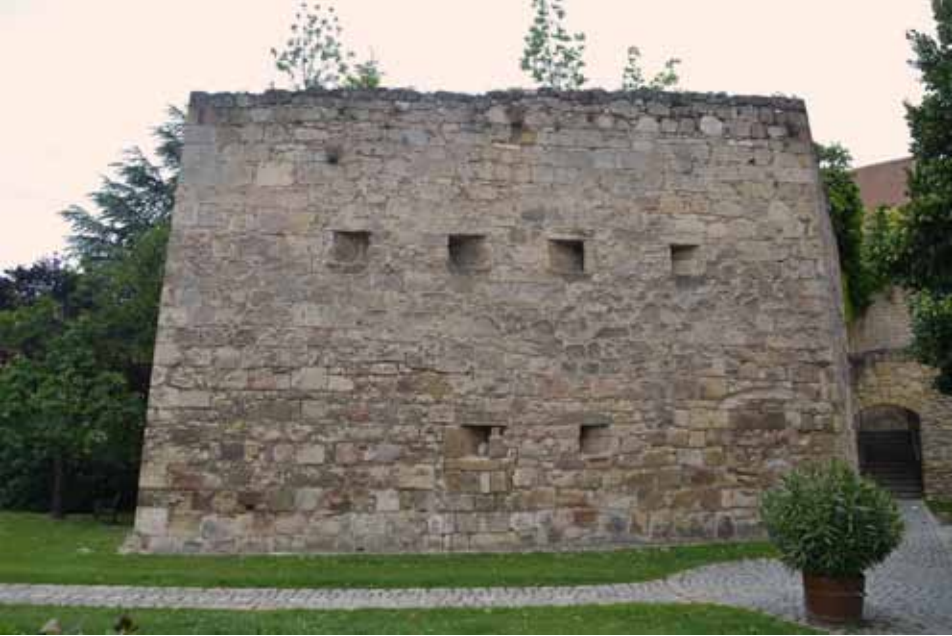
4. kép: Kismarton. A Lőportorony két homlokzati falán két szinten is találhatóak többágú lőrésesek (A szerző felvétele)
