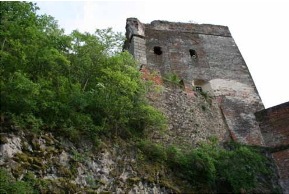
16. kép: Az alsorsori 10. teret magába foglaló északnyugati torony északi homlokzata a teherhárító ívekkel és alattuk az utólagos falkitöltéssel (fotó: Paul Mitchell)
