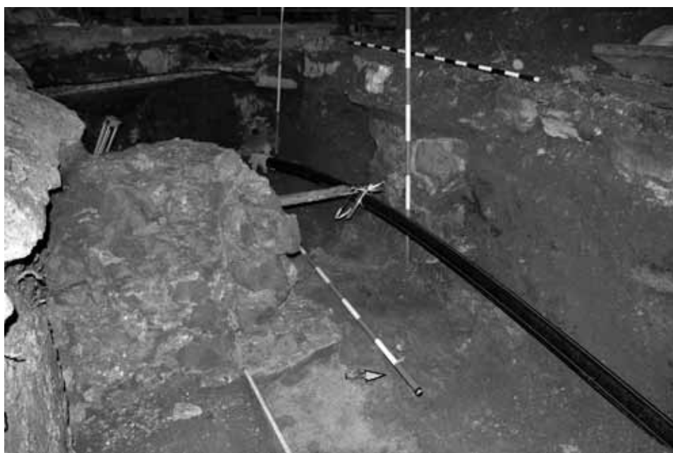
6. kép: A Varkoch-kapu farkasvermének közműekkel áttört keleti fala (a szerző felvétele)
