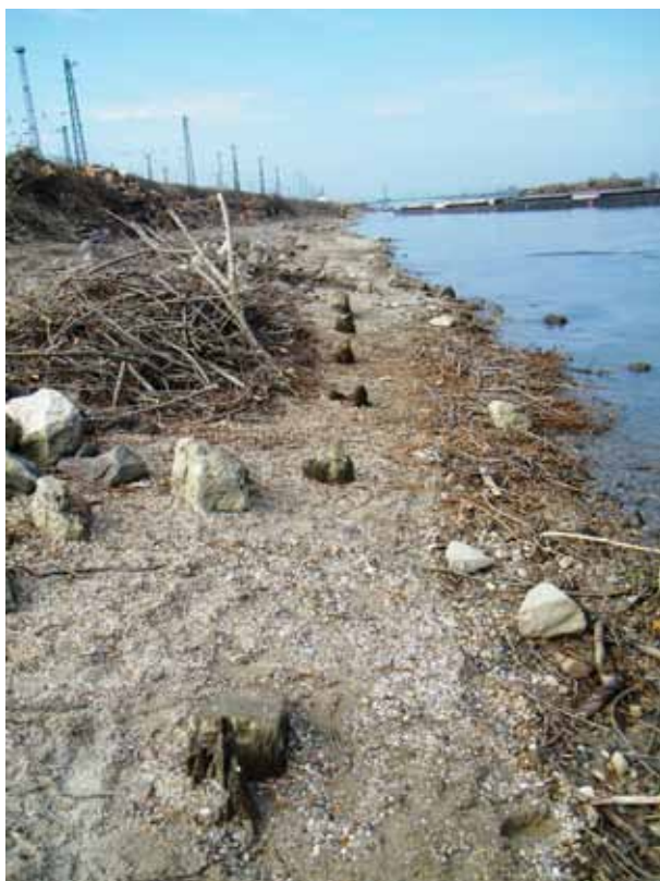
3. kép A dunai hídfő cölöpmaradványai (2014)
