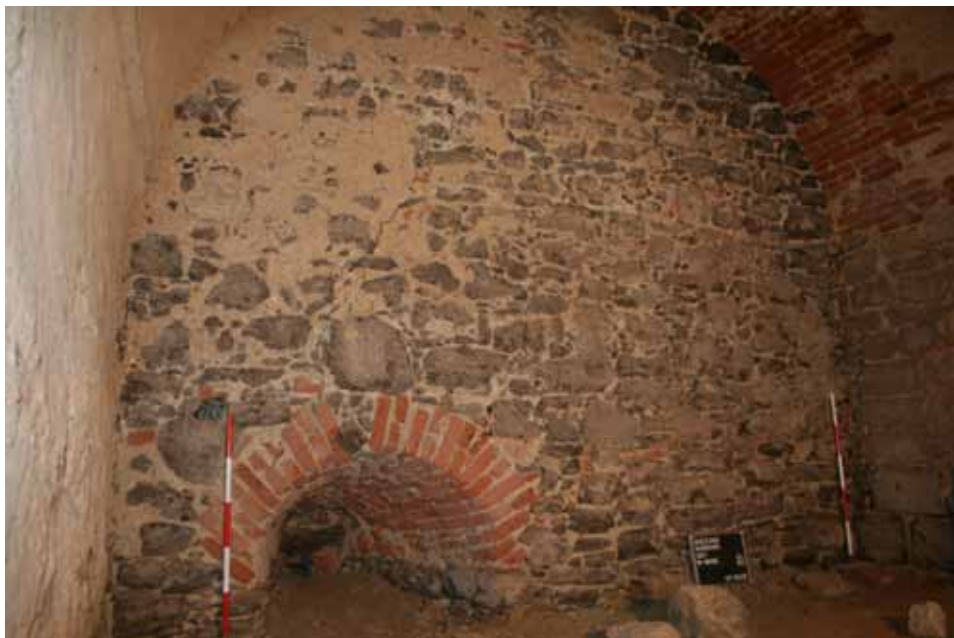
12. kép: Az alagsori 1. tér északnyugati fala, a lőrésablak bal oldali kávája eredeti, a jobboldali az áthidalással együtt újabb (fotó: Paul Mitchell)
