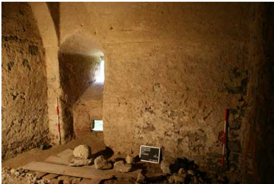
15. kép: Az alsorsori 1. tér délnyugati fala, jobbra elfalazott lőrés, balra utólag kialakított két, egymás feletti lőrésablak (fotó: Paul Mitchell)
