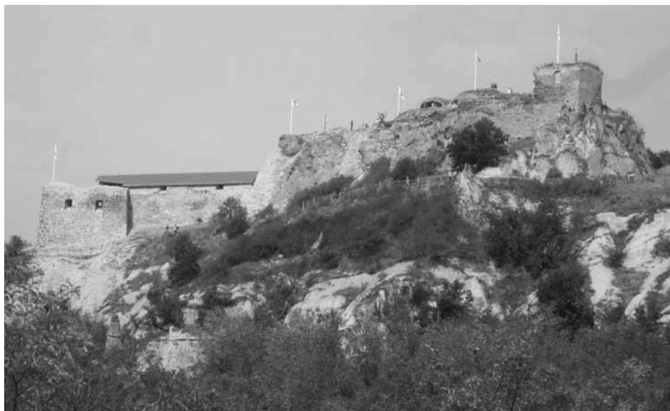
1. kép A siroki alsóvár a helyreállítás után dél felől
