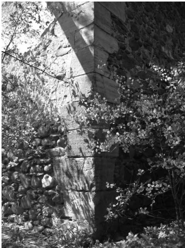
5. kép Az északkeleti sarok kváderarmírozása (a szerző felvétele)
