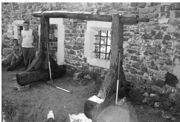
5. kép A várkútból előkerült és a helyszínen összeállított felvonószerkezet
