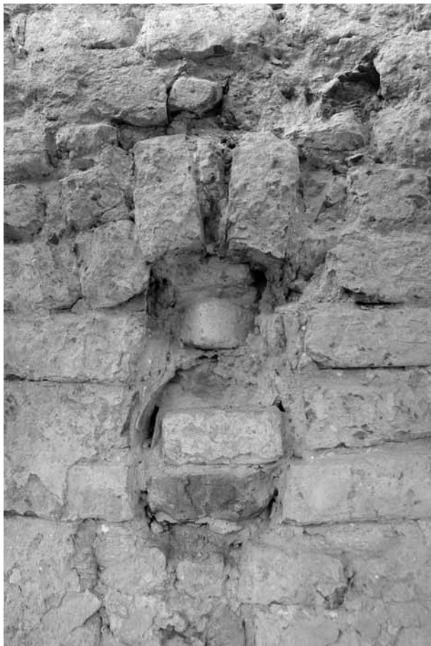
5. kép: A várkastély déli homlokzatának keleti felén, a második emelet magasságában talált kulcslyuklőrés. Fotó: Horogszegi Tamás.
