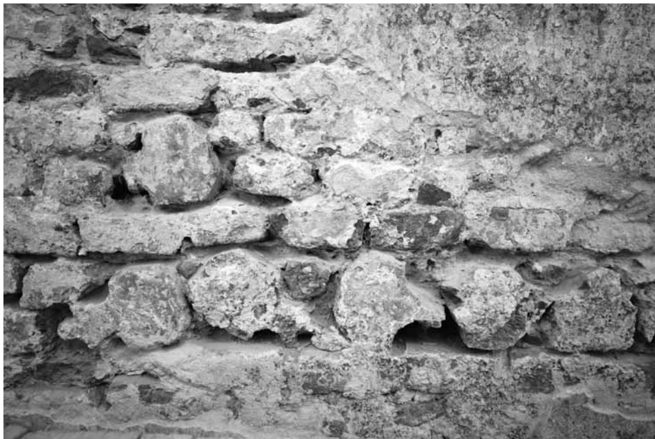
4. kép A várkastély északnyugati saroktornya északi homlokzatának első emeleti szintjén koncentráltan előkerült, másodlagosan befalazott gótikus kerámia bordák töredékei. Fotó: Gaylhoffer-Kovács Gábor.
