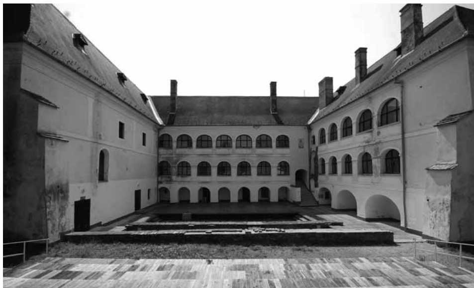
3. kép A várkastély udvara észak felől a kutatás előtt, 2010 áprilisában. Az udvaron az elbontott északi szárny alapfalainak felmagasítása látható. Fotó: Gaylhoffer-Kovács Gábor.
