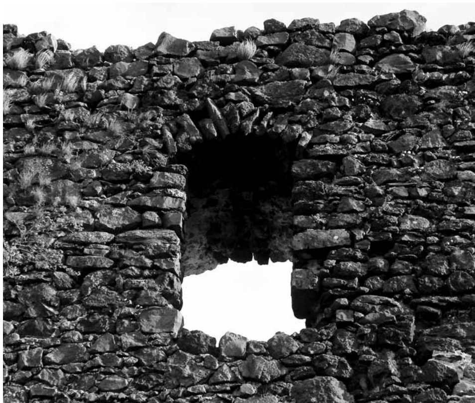
30. kép Az Öregtorony északi emeleti ablaknyílása
