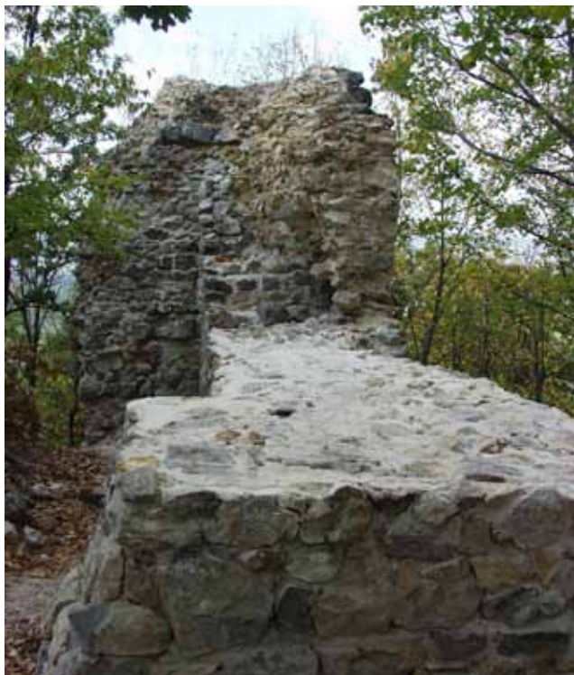
8. Dédes vára, a helyreállított falszakasz
