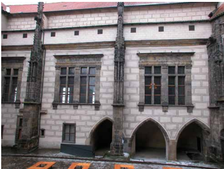
14. A királyi palota É-i udvara: gótikus és reneszánsz építészeti elemek a hosszanti szárny É-i homlokzatán (fotó: Magyar Károly)
