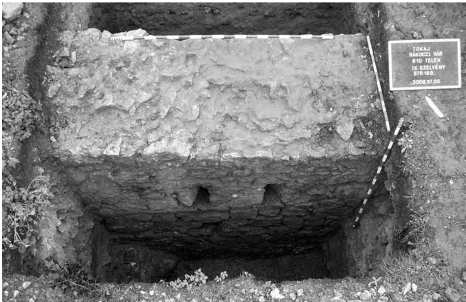
2. Tokaj, vár, a K-i ágyútoronyhoz (Vasaló-bástya) vezető kőhíd falának külső síkja a lőrésekkel
