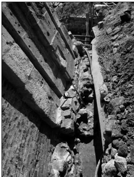
3. kép: A középkori Szt. János kapu toronyfalának alapozása modern roncsolásokkal Fig. 3: Basement of the tower wall of the Mediaeval Szt. János gate with modern disturbances
