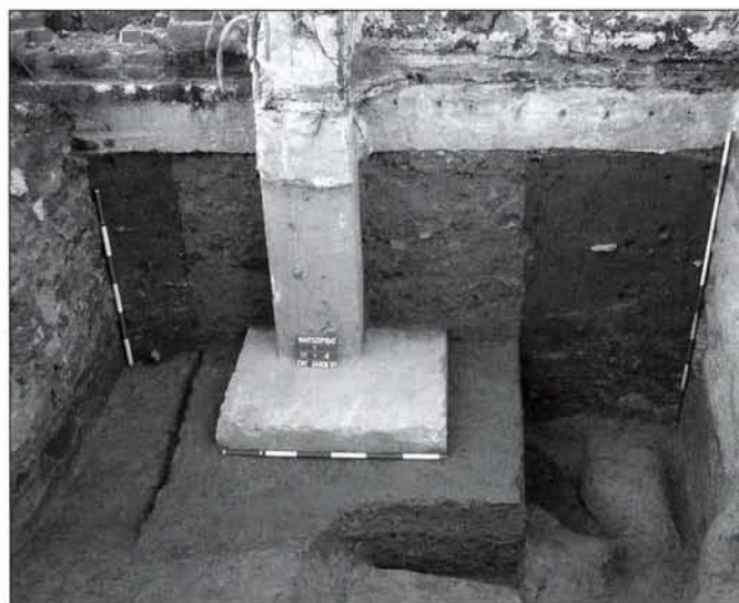
6. kép: Az „F” terület nyugati része régészeti rétegek metszetével és a kékfestőgyár pilléralapozásával (régészeti rétegek letről felfelé haladva: sárga-szürke agyagplanírozás, homogén szürke feltöltődés, köves járószint és végül szürke feltöltődés)
