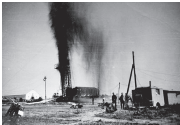
6. ábra. A vízkutató Tápé-1 fúrás vadkitörése 1965-ben (forrás: HORVÁTH Janina tudományos munkatárs, Szegedi Tudományegyetem, Földtani Tanszék)
