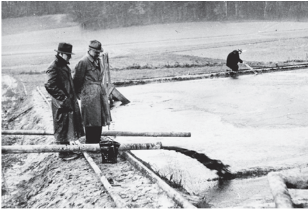
3. ábra. Az első magyar olaj. Budafapuszta-2 fúrás, 1204-1208 és 1168-1179 m mélységből, az ún. Kerettye pannóniai korú homokrétegből. A kezdeti olajtermelési ütem 12 mm-es fűvőkán napi 65 m 3 volt (PAPP 1965)
