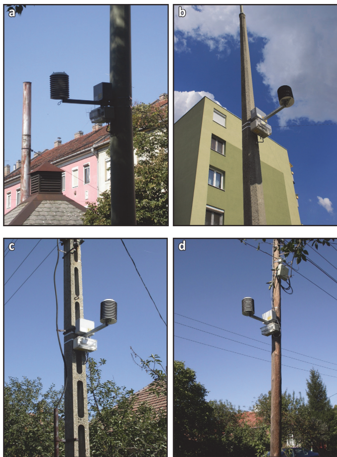
3. ábra: Néhány példa a mérőállomások elhelyezésére (a) acél és (b) beton kandelláberen, illetve (c) beton és (d) fa villanyoszlopon
